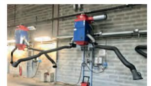
AV Aspirateurs de fumée de soudure 4 unités stationnaires et centrales d'aspiration et de filtration de fumée de soudage - 2 bras de 3000 mm articulés - Débit volumétrique max. de ventilateur (m³/h) : 3.500 - Pré filtre des particules : déflecteur - Filtre principal de particules : cartouche filtrante - Degré de séparation (%) : ≥ 99 - Tél : 03 88 68 01 37 - Mail : [info@cpmo.fr](mailto:info@cpmo.fr)
